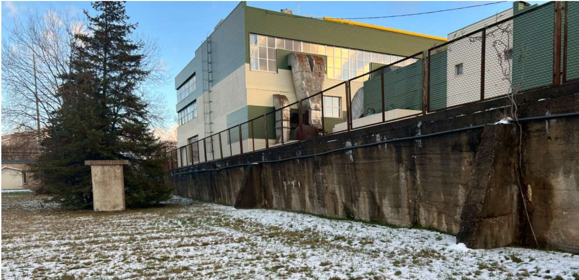
Pav. Nr. AR-2. Remontuotinos sienutės fragmentas
